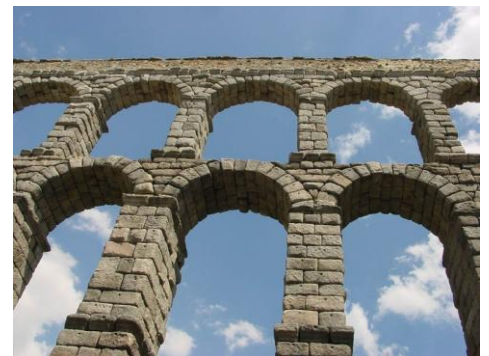
Aqueduc de Ségovie, vue en contre plongée
